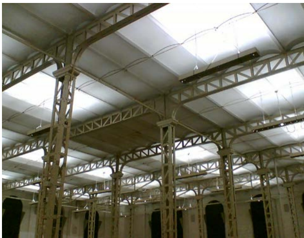
Rauminstallation, 35 vorhandene Beleuchtungskörper
